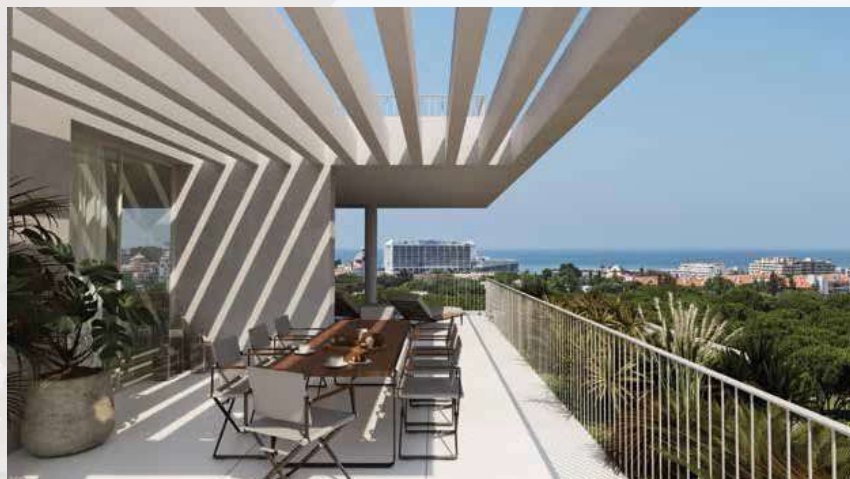
Vista das varanas laterais (na fachada a poente) dos últimos pisos
