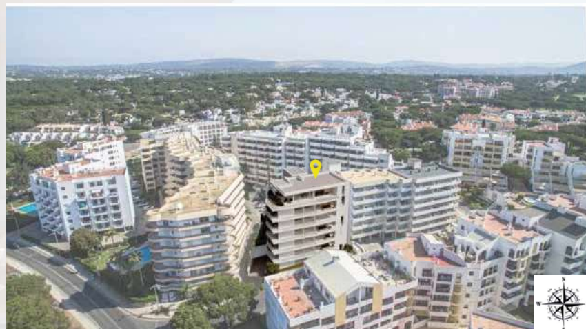
Vista do alçado principal do edifício Voltado a Sul
